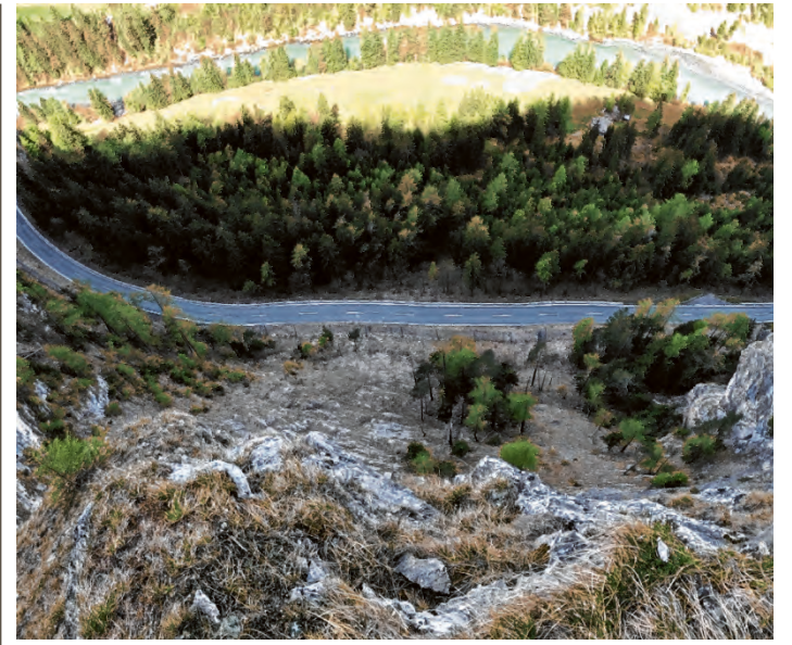
Auf der Reschenstraße sind derzeit Felssicherungsarbeiten im Gange – zur Sicherheit der Verkehrsteilnehmer, wie das Land betont. Foto: Land Tirol
