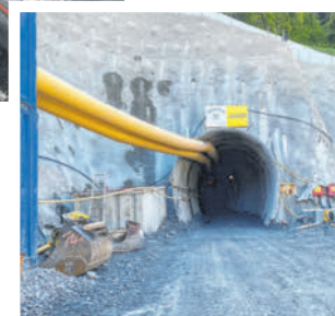
Derzeit werden Leitungen in den Elisabeth-Stollen verlegt.
