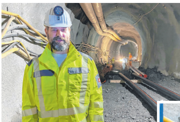
Leiter des Megaprojekts ist Bernhard Braza. Den VN gibt er einen Einblick in den 250 Meter langen Altstadtstollen. VN/RAU
